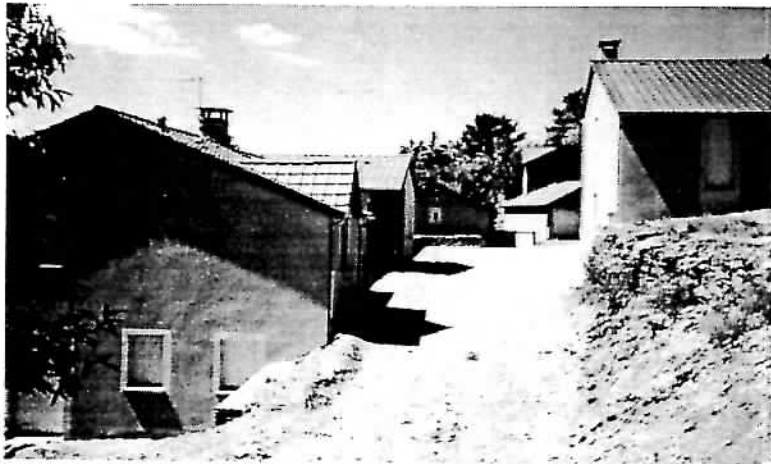
Le hameau de l'Ayrolle et ses trois nouvelles maisons prêtes à accueillir leurs locataires.
