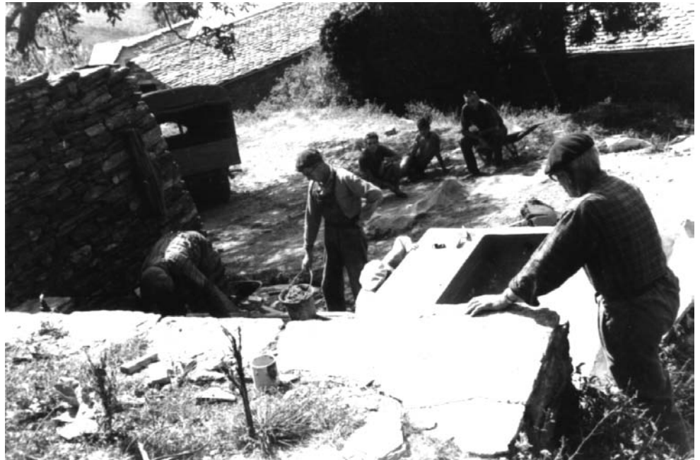
Construction du lavoir (1965).
