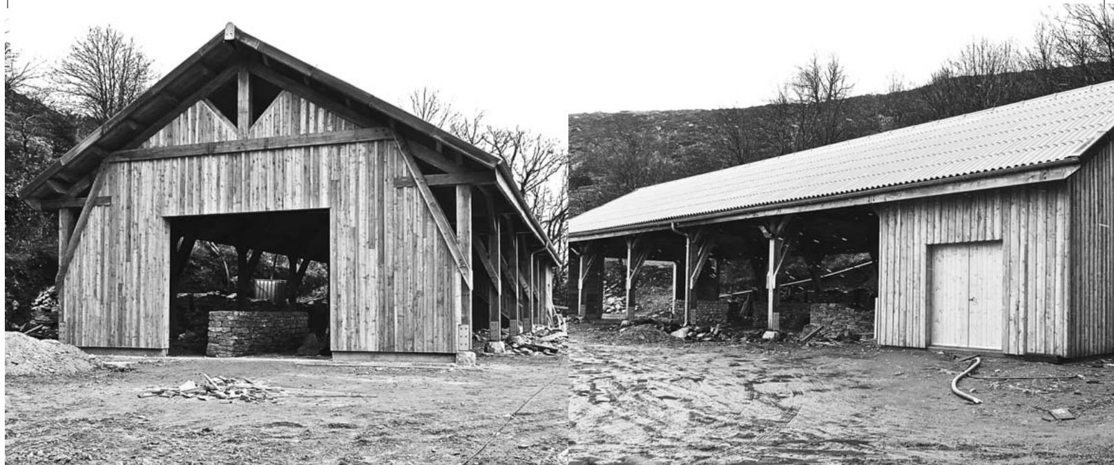
L'atelier-hangar de l'Espinas pignon ouest (photo de gauche) et bardage bois terminé (photo de droite)
