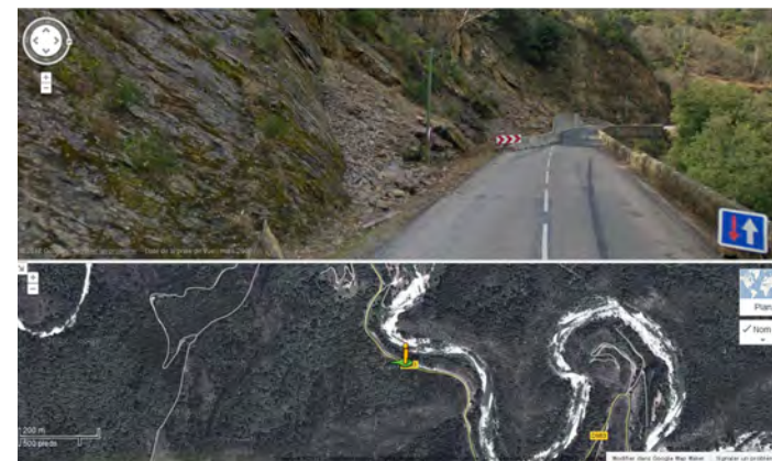
Neutralisation 1/2 voie - RD 983 à Saint Etienne Vallée Française (source géorisques)
