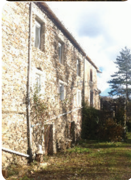
Construction traditionnelle à Saint-Michel-de-Dèze bourg
