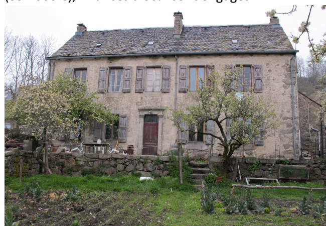
Le presbytère avant travaux
