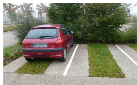
Traitement de sol perméable
