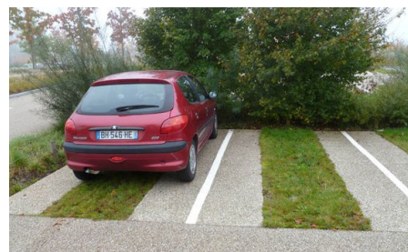
Traitement de sol perméable
