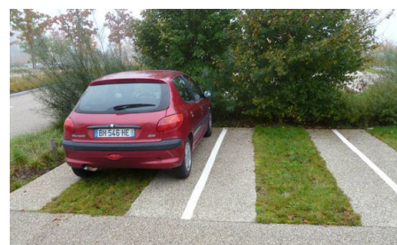
Traitement de sol perméable
