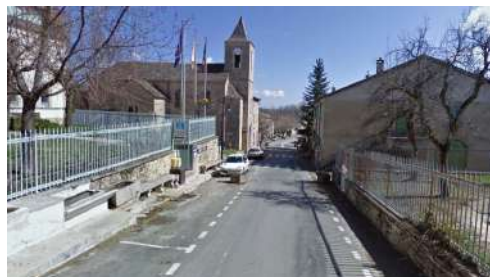
Stationnements le long de la Corniche des Cévennes sur la commune du Pompidou - Google Street View
