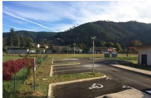
Effet «mité» de l'espace ouvert - Source : Géoportail
