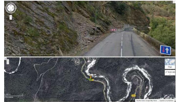
Neutralisation 1/2 voie - RD 983 à Saint Étienne Vallée Française (source géorisques)
