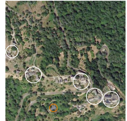
Multiple noyaux bâtis, Masbonnet, Pompidou - Source : Géoportail
