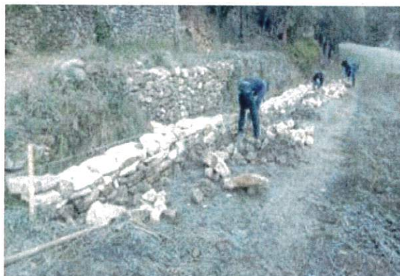
Illustration 2 : travaux de restauration d'alimentation en eau de la zone humide (pré humide méditerranéen) avec une association d'insertion – novembre 2021
